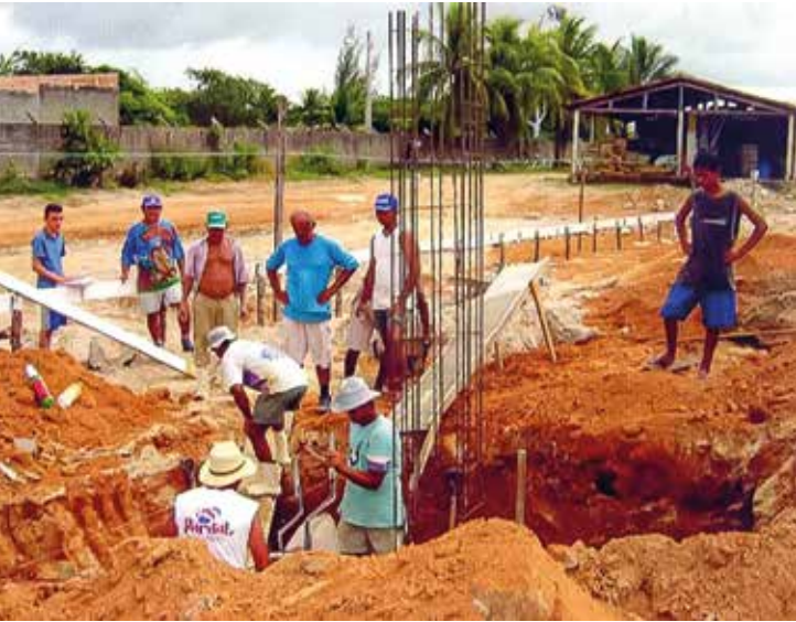
Construção da fábrica no Eusébio
